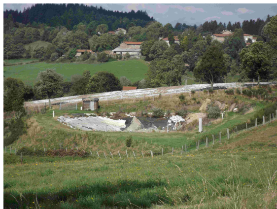
Bassin aval de la lagune d'en haut Le 21/09/24
